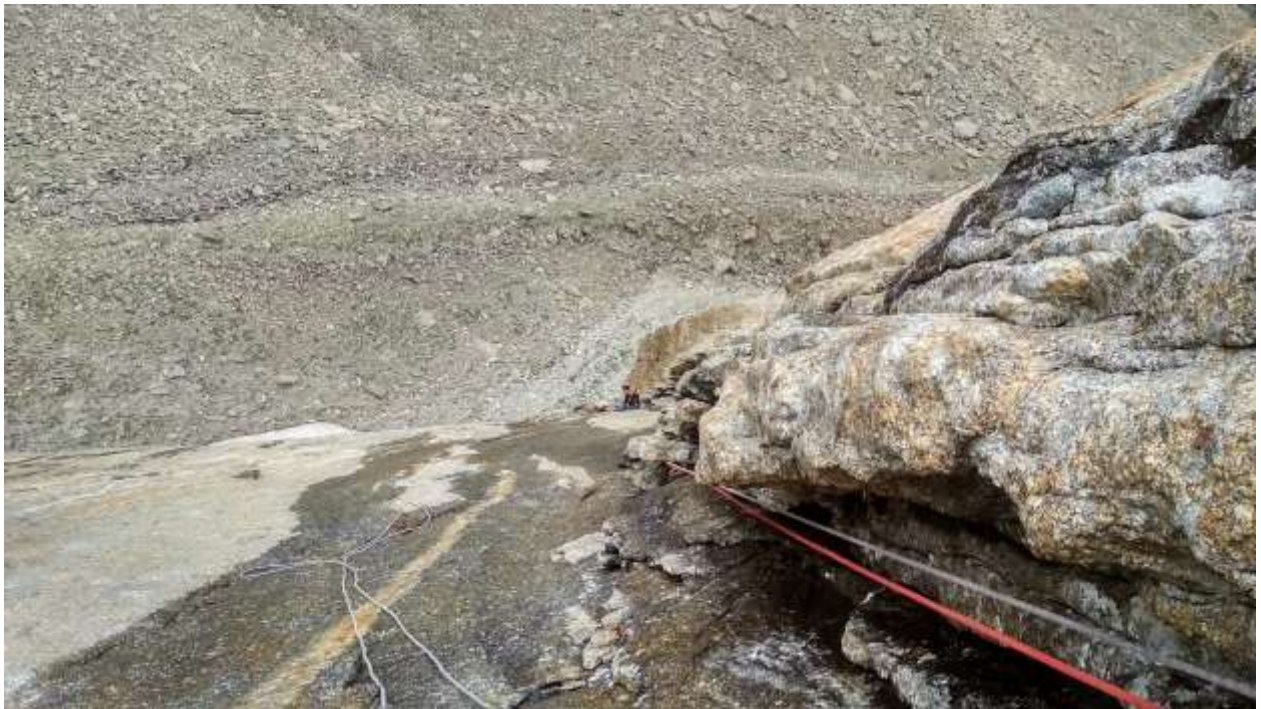
Участок R7-R8 вид сверху
