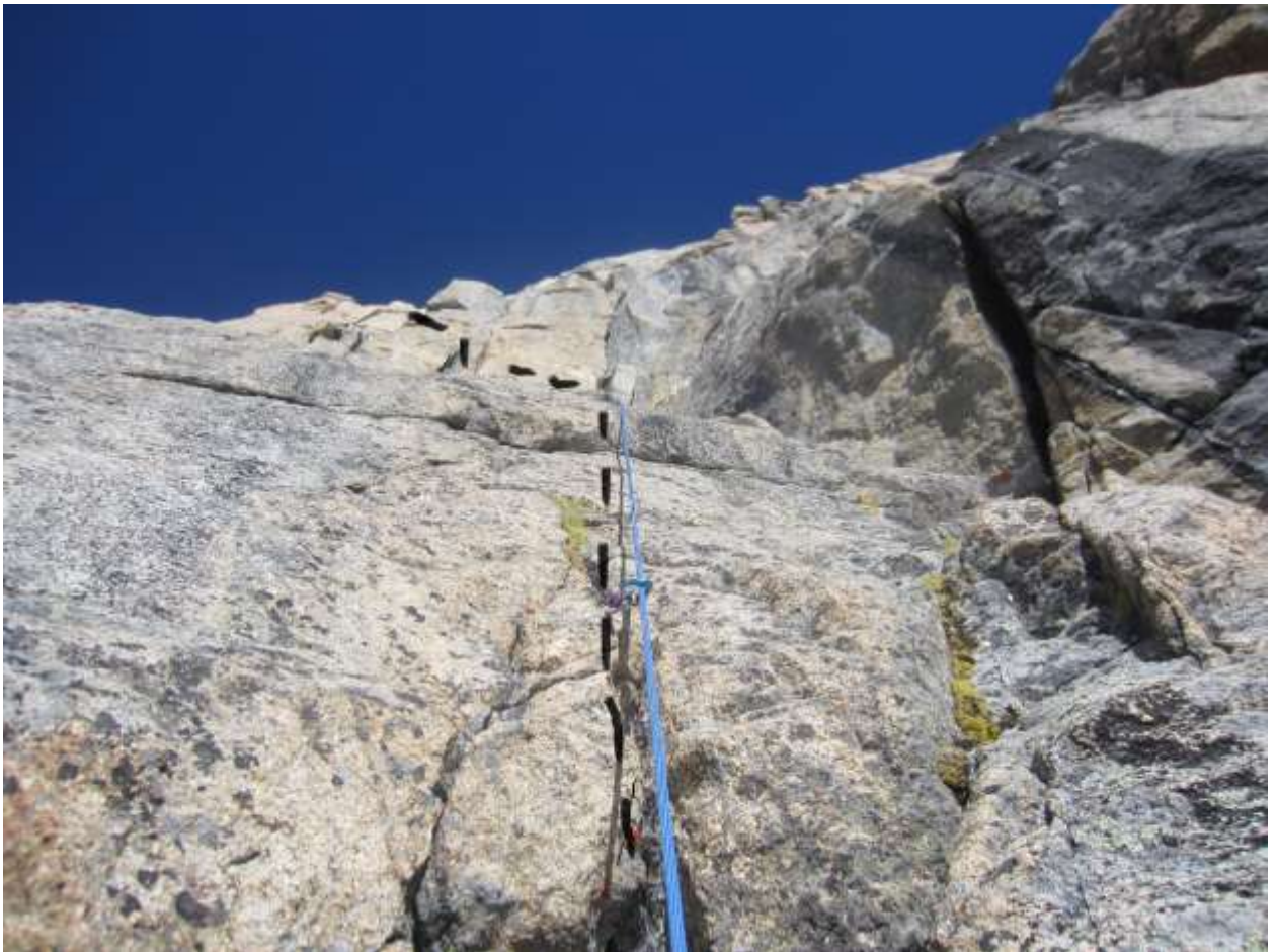
Вид снизу на участок R3-R4, вверху видна стенка с двумя трещинами.
