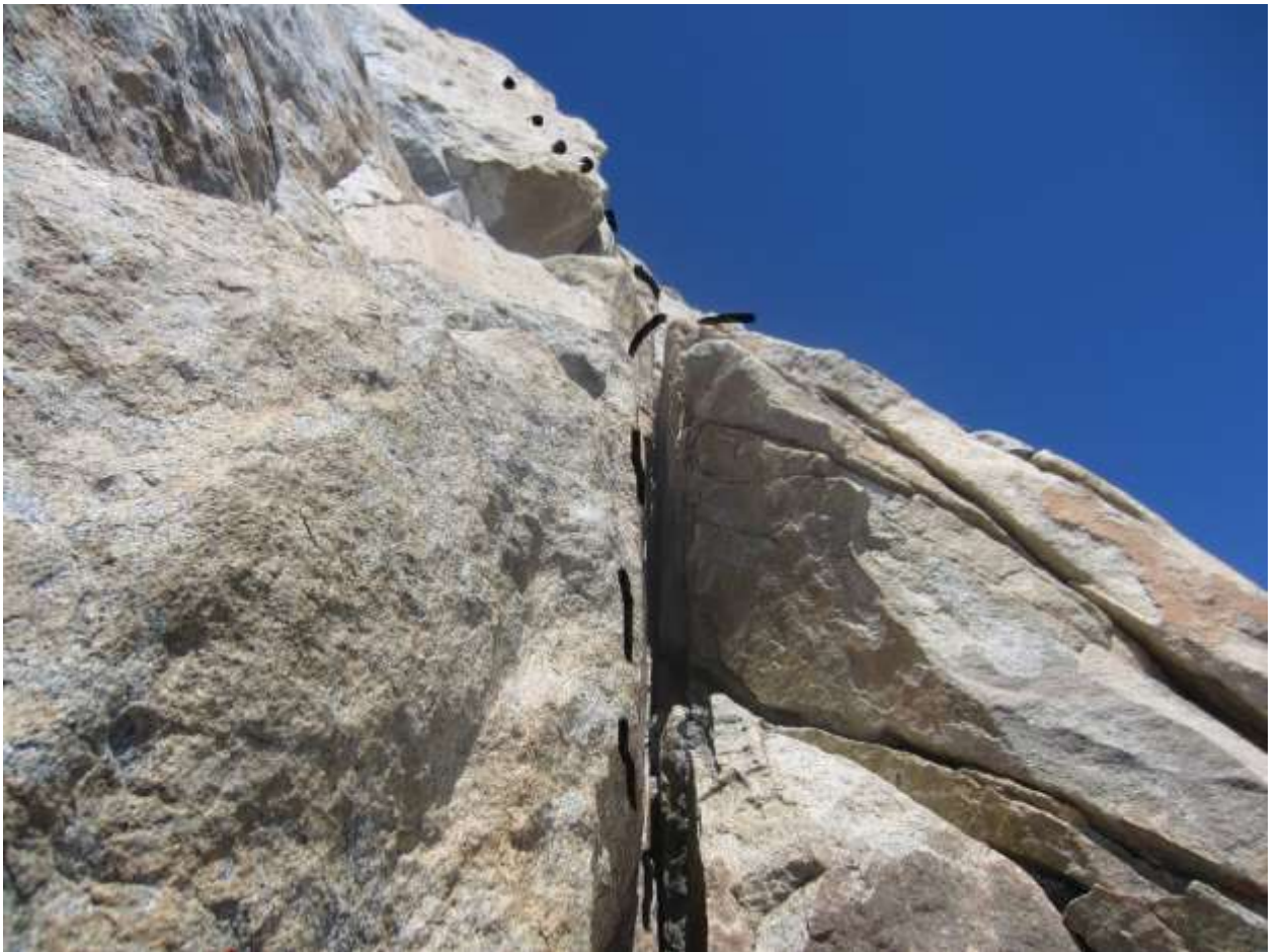
Вид снизу на трещину, участок R7-R8.
